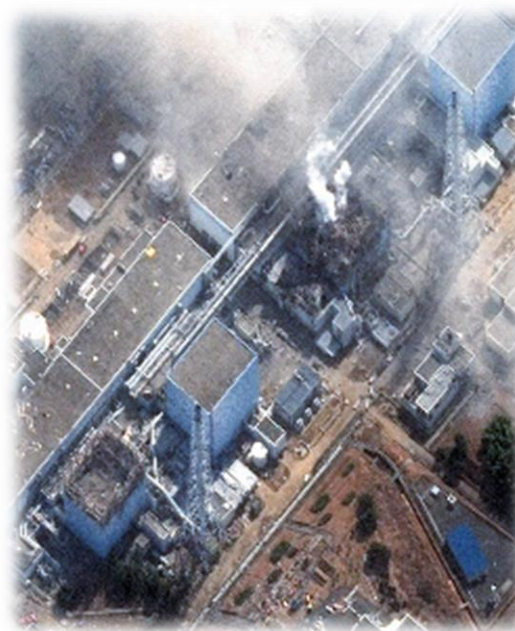
東京電力 福島第一原子力発電所
